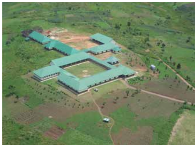
Escuela universitaria de Ingeniería Civil en la ciudad de Mahagi (El Congo) puesta en marcha por la empresa TYPESA
